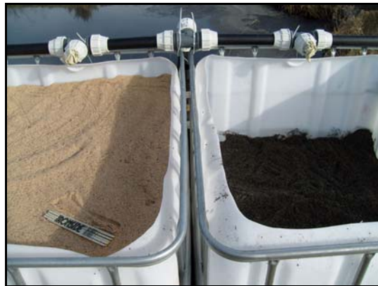
Abbildung 6: Einbringen des Substratgemisches aus Sand und Pflanzenkohle (rechts), Filterkörper mit abschließender Sandabdeckung (links)
